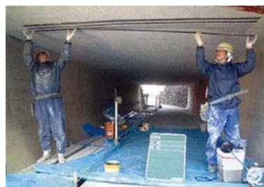
写真3 スラブ補強の例
