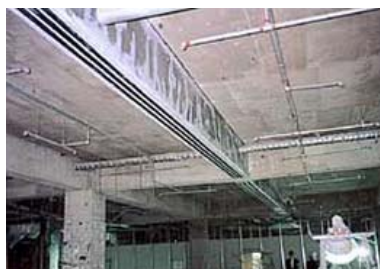
写真2 梁補強の例
